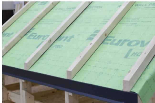
Поверх диффузионной мембраны на стропила смонтируйте контробрус размером 50x50 мм.
