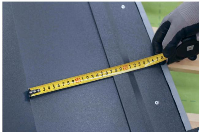
Смонтируйте крепёжную планку по обеим сторонам ендовы в 150 мм от центра ендовы. На месте стыка планок используйте кровельный герметик. Монтаж крепёжной планки осуществите с помощью вытяжных заклёпок.
