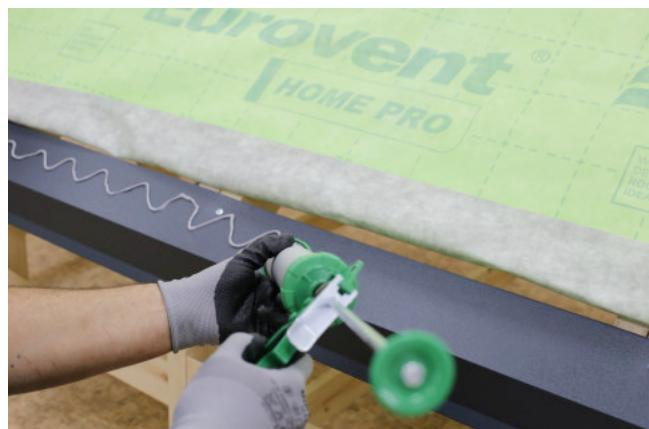
Поверх стропильной системы смонтируйте диффузионную мембрану с помощью строительного степлера. На капельнике диффузионную мембрану закрепите при помощи клея-герметика или двустороннего скотча.
