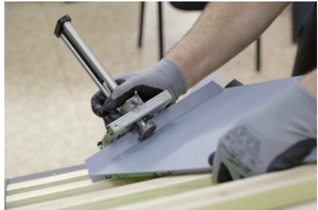
Сделайте загиб на 180°, длиной 25 мм. Загиб возможно выполнить двумя способами: с помощью гибочной рамки для карниза или с помощью роликового листогиба.
