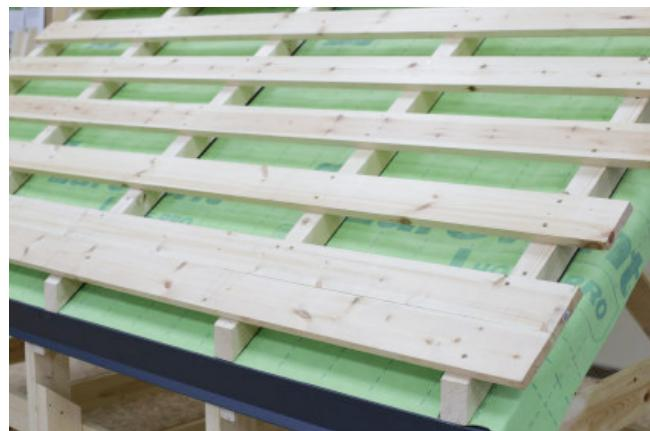
Затем на контробрус карнизного свеса смонтируйте первые 2 доски обрешетки без зазора. Помимо этого монтируйте с шагом в зависимости от угла наклона кровли (таблица 4). Рекомендуем использовать доски с влажностью не более 20% и толщиной не менее 25 мм для монтажа обрешётки.
