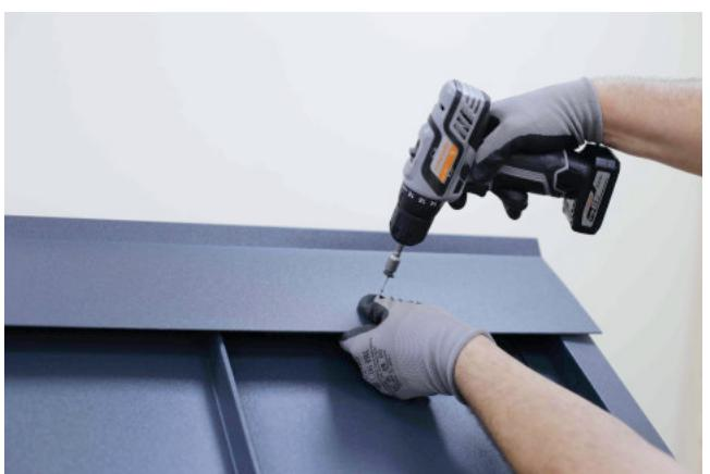
Установите коньковую планку на место. Закрепите ее с помощью саморезов к опорной планке конька на расстоянии 480 мм. Нахлест на коньковую планку должен составлять не менее 100 мм.
