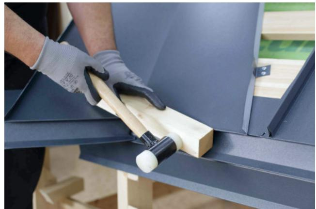
С помощью бруска и киянки обеспечьте плотное прилегание планки ендовы к карнизу.
