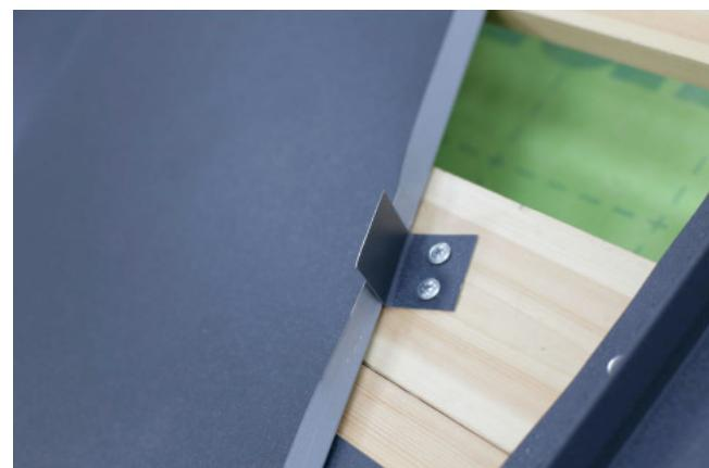
Закрепите ендово на кляммеры с шагом 400-500 мм. Планка ендовы укладывается от карниза к коньку с нахлестом 300 мм.
