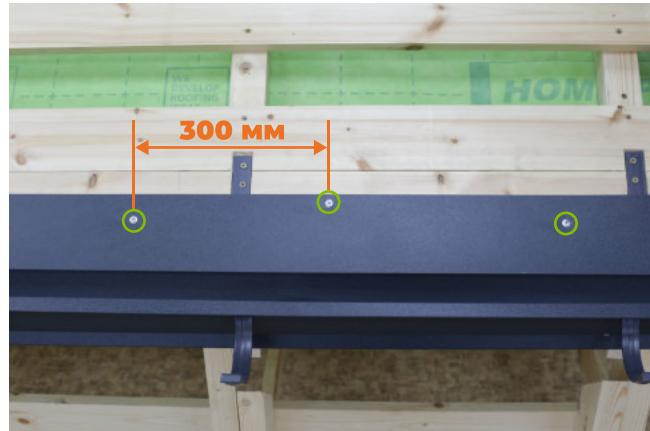
Смонтируйте карнизную планку, выравнивая по уровню. Поверх крюков на обрешётке закрепите карнизную планку саморезами ШСММ 4,2\*19 мм с острым сверлом в шахматном порядке с шагом 300 мм. Монтаж карнизных планок осуществляется внахлест.
