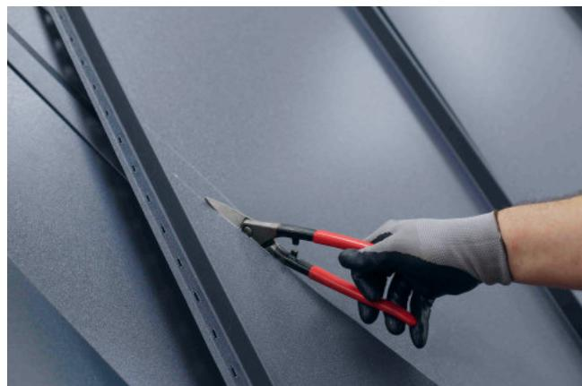
Сделайте отступ 25 мм на загиб за крепёжную планку. Проверьте соответствие размера и формы среза необходимым параметрам по углу и длине. Срежьте лишнюю часть картины по намеченной линии.
