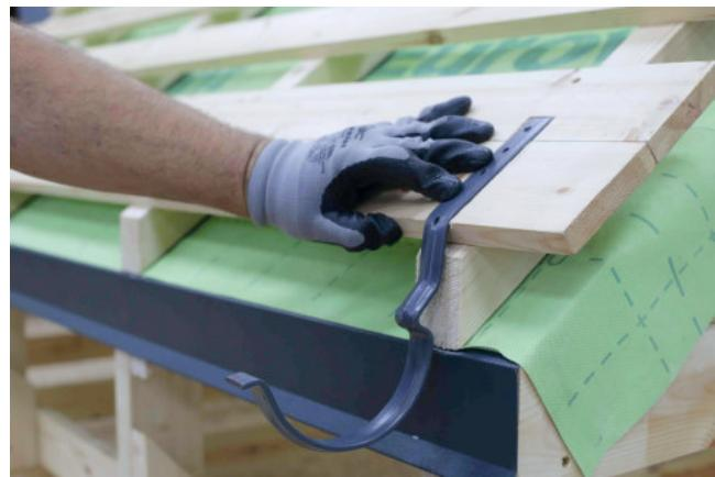
Для монтажа длинных крюков водосточной системы сделайте разметку и паз в обрешётке. Далее смонтируйте водосточные крюки в пазы оцинкованными саморезами с шагом, рекомендованным производителем. И крюки, и саморезы должны быть в плоскости обрешётки.
