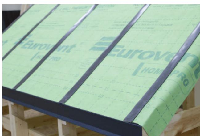
На стропила смонтируйте уплотнительную ленту для дополнительной гидроизоляции в местах крепления контробрешётки.
