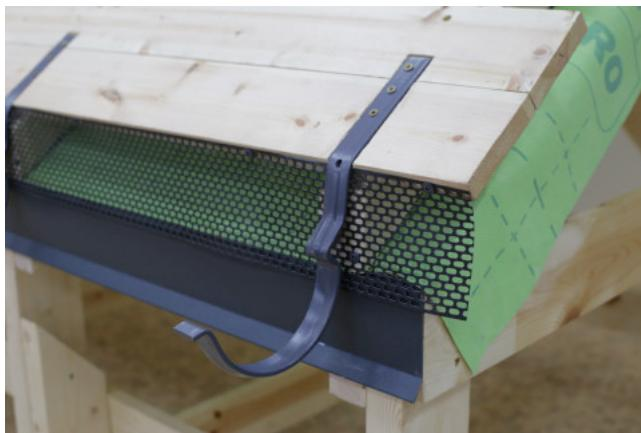
Перед монтажом карнизной планки установите вентиляционную карнизную ленту между капельником и начальной доской обрешётки, для защиты подкровельного пространства от насекомых и птиц.
