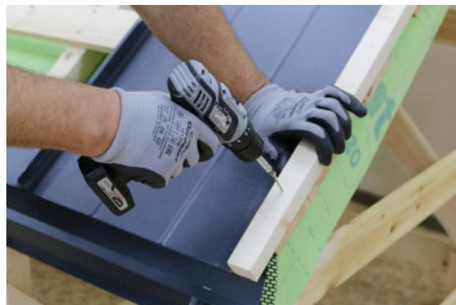
Край картины закрепите кляммерами. Смонтируйте бруск 30 x 30 мм поверх кляммера параллельно картине, закрепите бруск для последующего монтажа торцевой планки.
