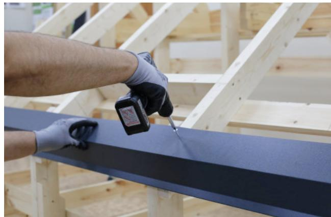
Перед монтажом диффузионной мембраны смонтируйте планку карнизную (капельник) вдоль карнизного свеса, используя саморезы ШСММ 4,2\*19 мм.
